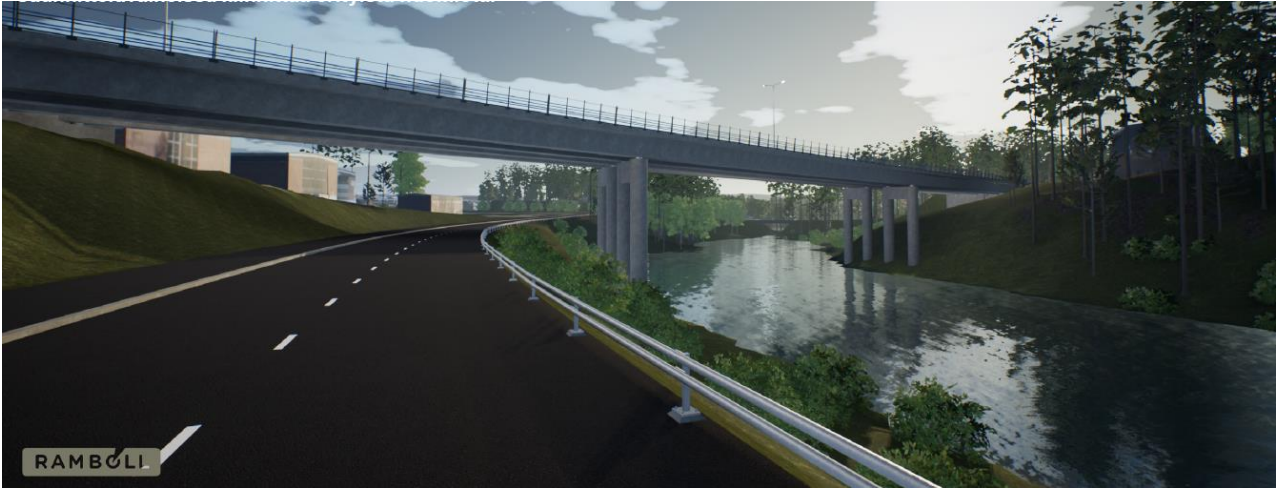
Näkymä Haapaniementieltä etelästä ohitustien ja sillan rakentamisen jälkeen. Sillalla on läpinäkyvät kaiteet.
