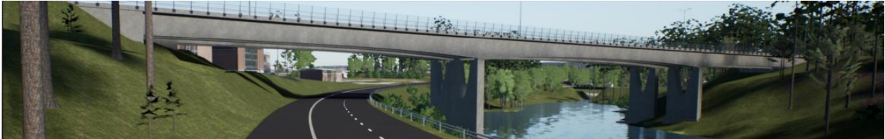
Varaslahden silta etelästä päin katsottuna, Haapaniementie alittaa sillan.
